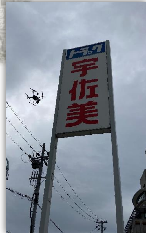
ドローンによる建植広告塔点検
